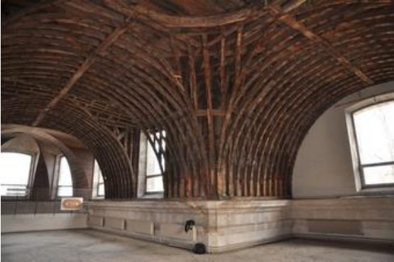
Travaux de réhabilitations
