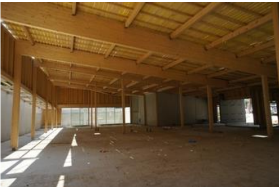
Travaux de charpentes lamellées collées
